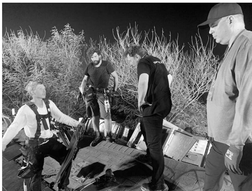
Kiểm tra việc lắp đặt mái năng lượng mặt trời với Brian Dow ở ngoài cùng bên phải
